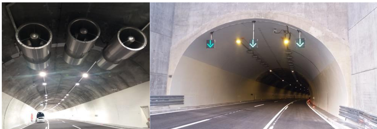
Slika 39: Prezračevanje v predoru Golovec Slika 40: Prenova predora Golovec
