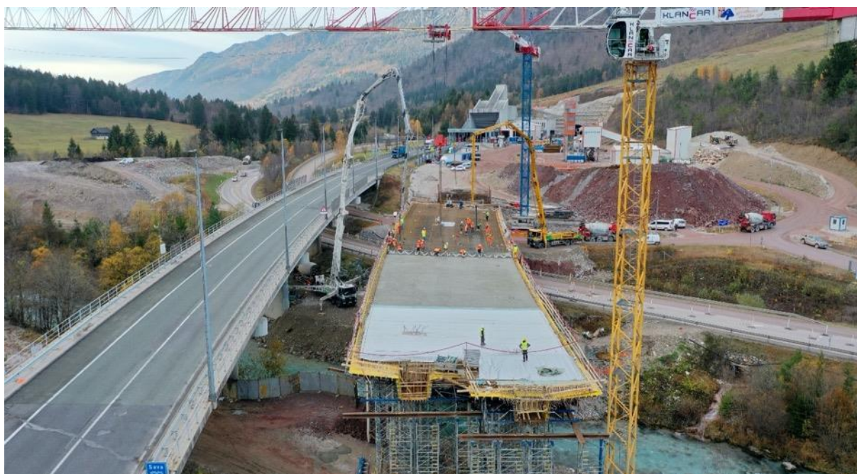
Slika 8: Betoniranje prekladne konstrukcije mostu M-1 (I. faza)
