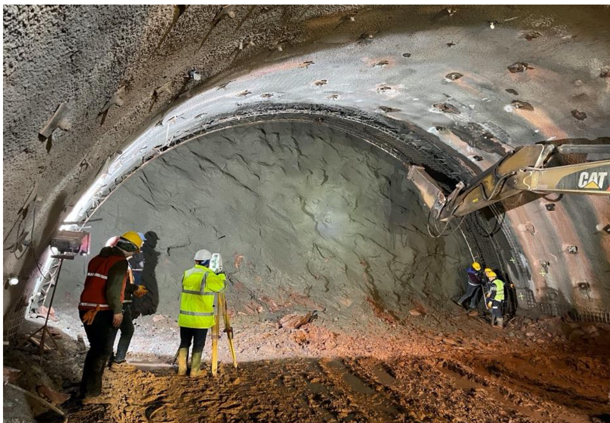
Slika 7: Postavitev paličnega loka v kaloti predora
