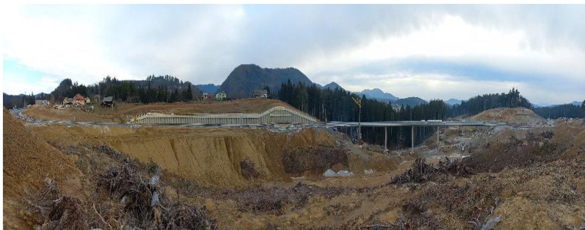
Slika 9: Pogled na gradbišče sklopa D – Gaberke
